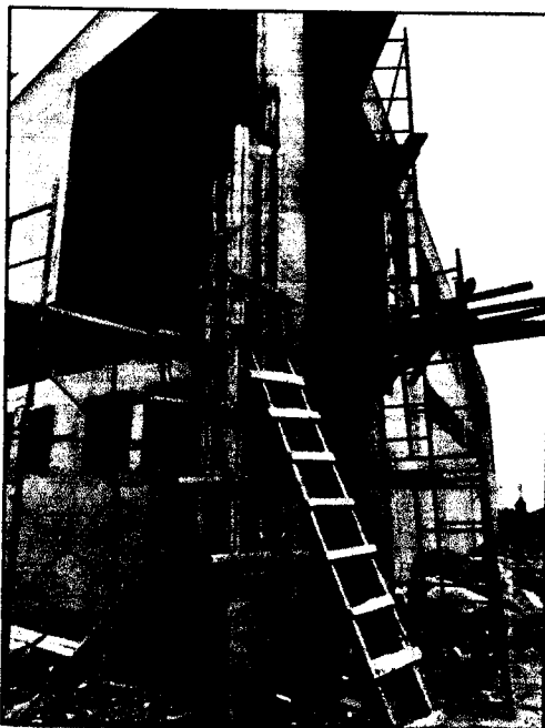
Columna de concreto armado del portón de ingreso
